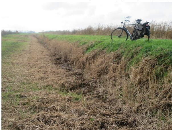
Het hoogteverschil tussen wegdek en slootbodem is dermate groot, dat er voldoende grond aanwezig is om de beide sloten langs de Kasteeldreef te dempen
