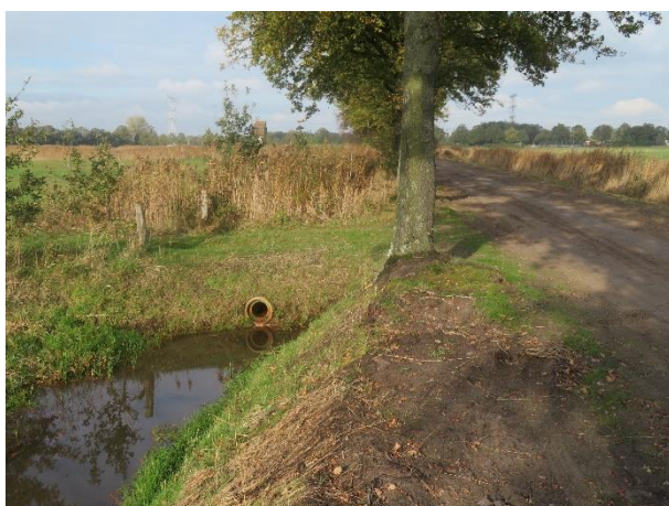
Aan de westzijde van de Elsdijk stroomt via de duiker gebiedseigen water uit het weidevogelgebied rechtstreeks de Rosep in
