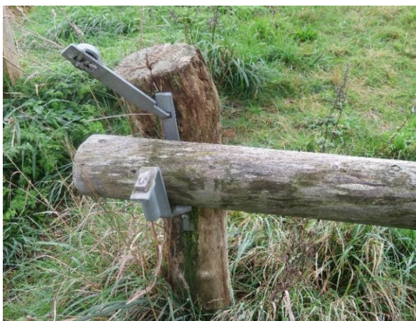
Slagboomsluitingen staan regelmatig open. Een aangebrachte constructie met hangslot voorkomt de toegang van ongenodigde voertuigen.
