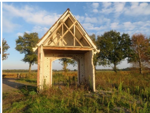
Bij voldoende nestgelegenheid aan de til, kan deze bouwval worden afgebroken
