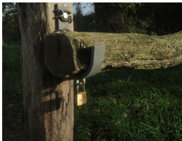
Slagboomsluitingen staan regelmatig open. Een aangebrachte constructie met hangslot voorkomt de toegang van ongenodigde voertuigen.
