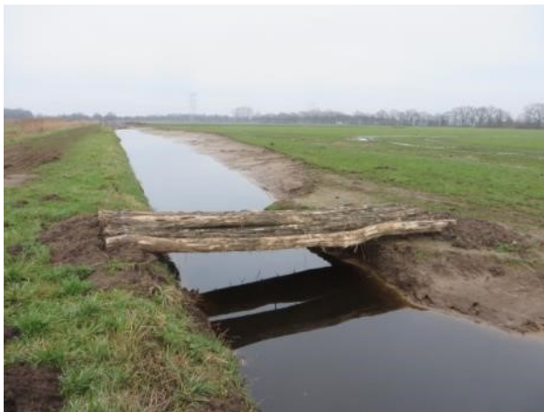
De pas aangelegde 'pullenbrug' over de sloot langs de Kasteeldreef, de zandlaag erop is nog niet aangebracht. Aan de binnenzijde van het weidevogelgebied is één oever van de sloot afgeschuind. De 'pullenbrug' na een jaar. Vanaf de Kasteeldreef is het weidevogelgebied voor bijv. predatoren vrij toegankelijk
