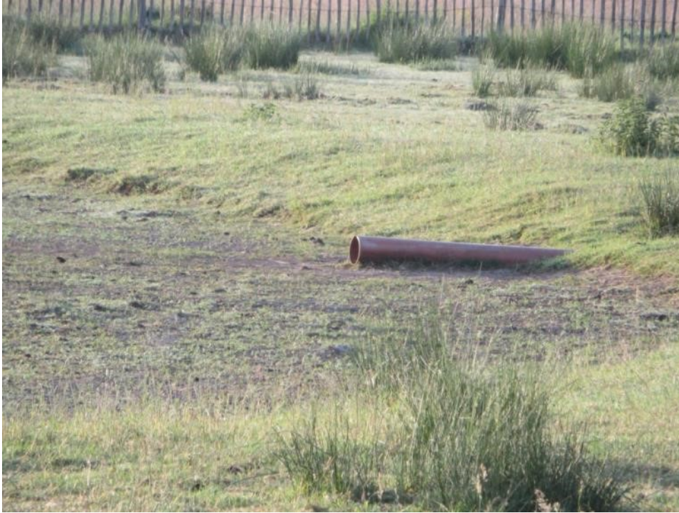
De ingegraven buis in het Helsbroek van ca. 150 meter lengte, waar het water uit de Reusel doorheen wordt gepompt om de ijsbaan te vullen
