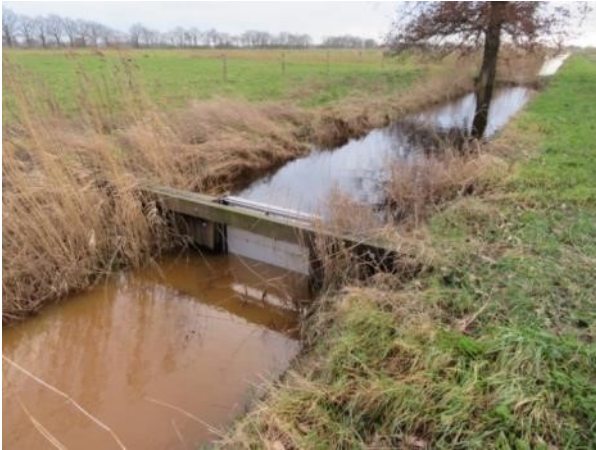
O.a. in de sloot langs de Kasteeldreef zijn stuwen geplaatst om de afwatering van gebiedseigen water te beperken.
