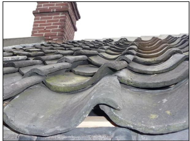
Postelstraat 1 na renovatie
