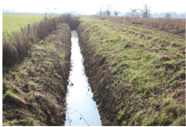
Kasteelweg. De sloten en bermen weerszijden van deze zandweg blijken ook na de inrichting geschoond en gemaaid te worden, alsof het een agrarische gebied betreft
