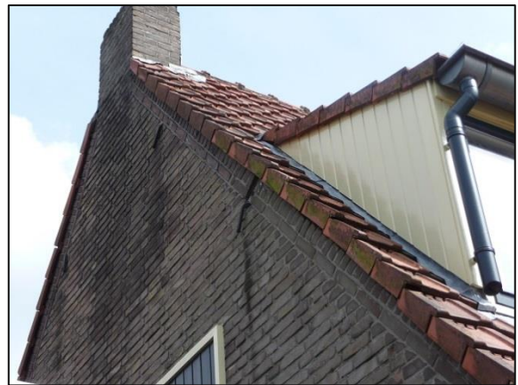
Tilburgseweg met jaarlijks minimaal één broedgeval onder de pannen.
