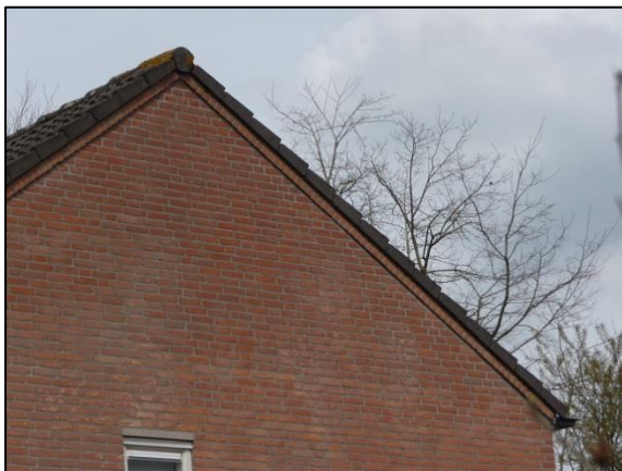
De Hoefkens, huizen met gevelpannen
