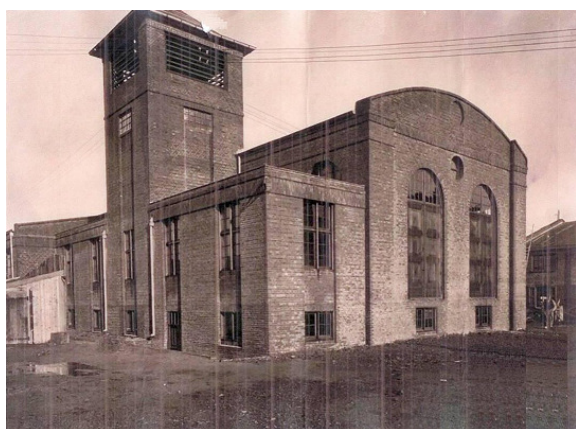
Het ketelhuis zoals het er in het midden van de vorige eeuw uitzag. Door de toren van het ketelhuis lopen elektriciteitsdraden van en naar de transformator.
