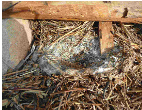
4 nestjes op een rij, de bovenste twee (rechts op de foto) nog in aanbouw (foto boven)
