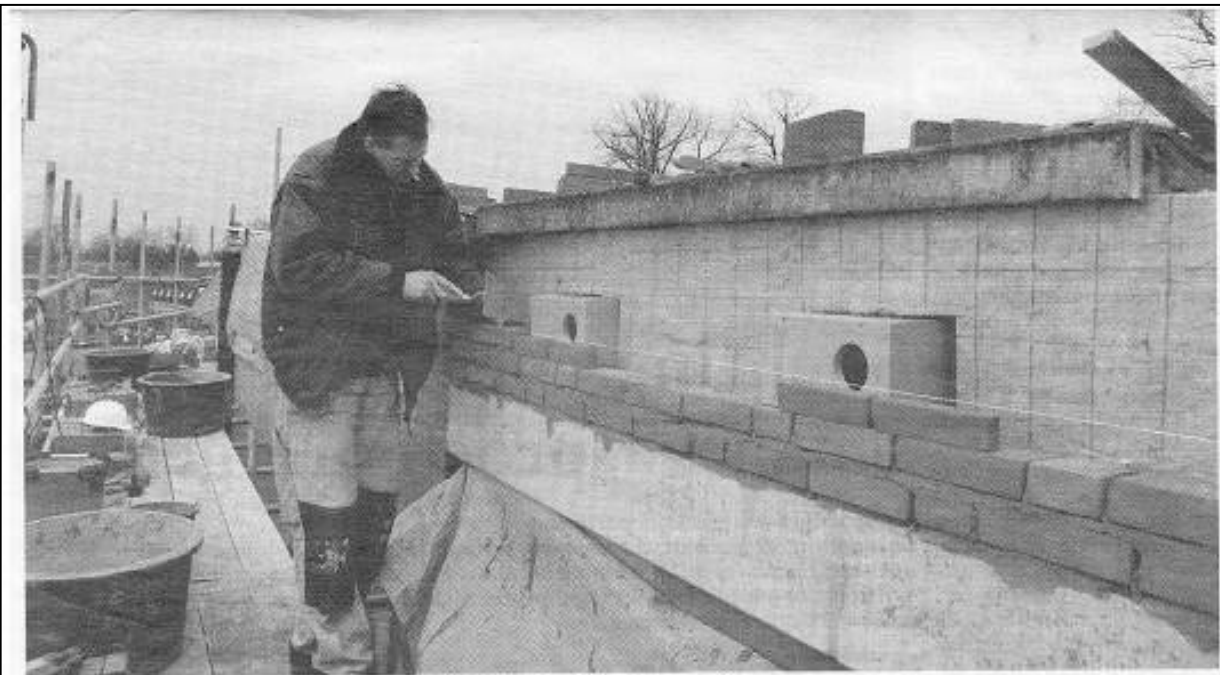
Gierzwaluwkasten worden bij Stromenland ingemetseld. (foto: Gerard van der Kaa)
