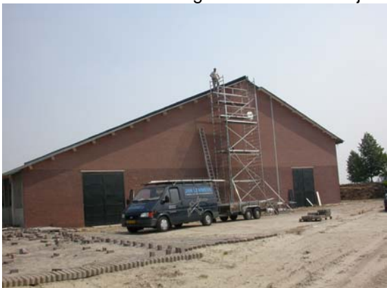
Foto 5 En... het aanbrengen van de overstek aan de achterkant van de nieuwe schuur.
