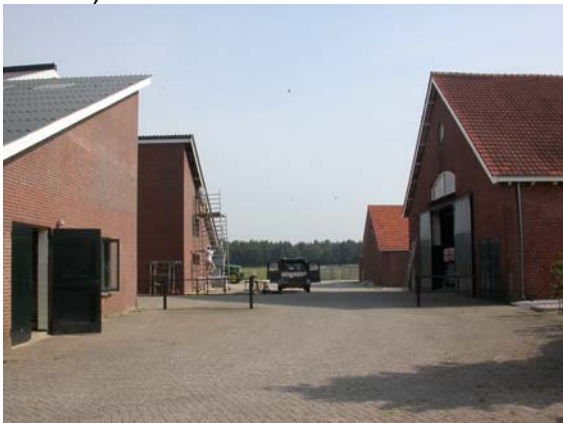
Foto 4 Het aanbrengen van de overstek aan de nieuwe schuur tegenover de boerderij
