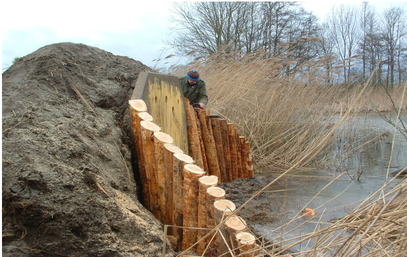
Foto 8: Het vormen van de zandkering aan beide zijden van de wand
