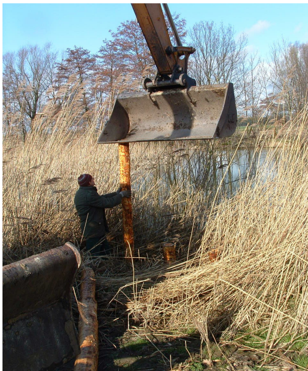
Foto 5: Heipalen worden in de kleigrond gedreven
