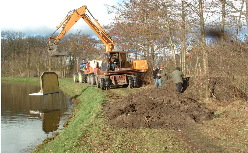
Foto 7: Het manoeuvreren van een element naar z'n definitieve plaats
