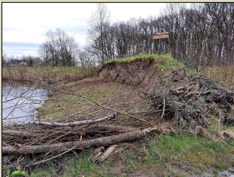
De herstelde oeverwaluwand.
