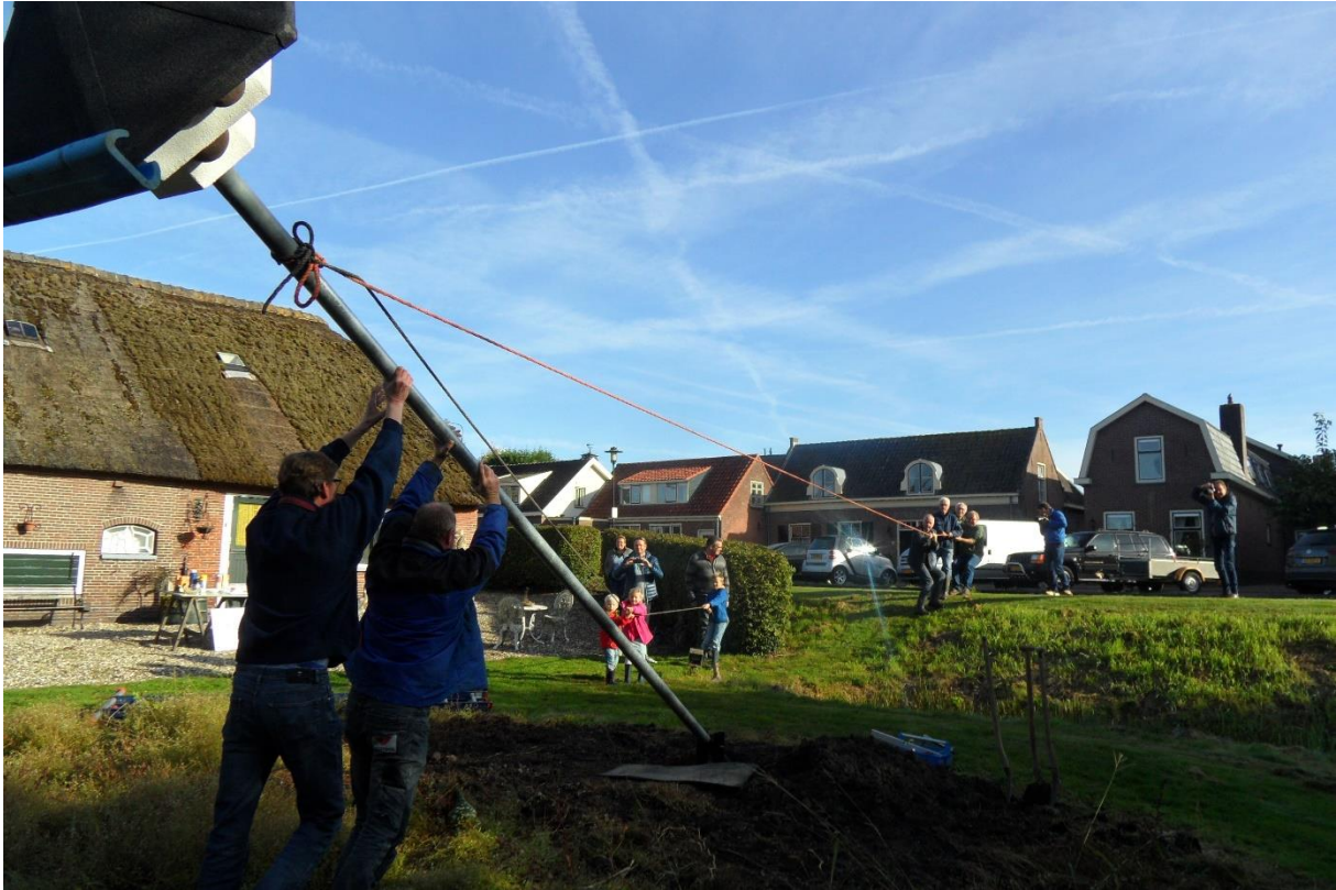
Plaatsing til in Kockengen, UT. Fotograaf onbekend.
