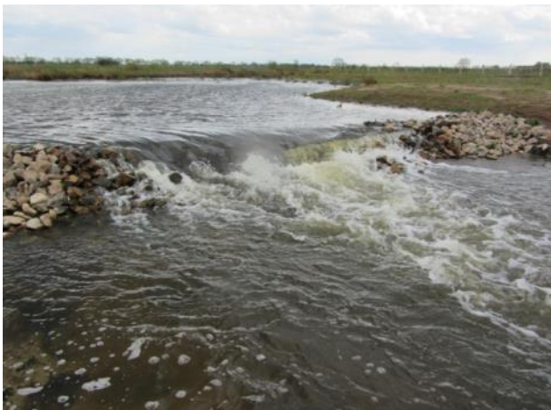
Om het water in de Reusel op te stuwen om het kanoën mogelijk te maken, werden in 2012 nieuwe dammen in de beek gelegd
