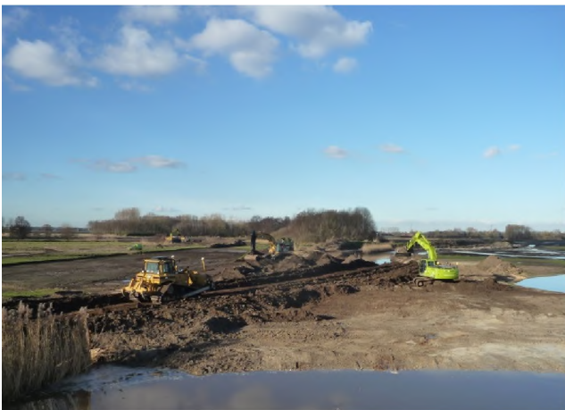
Foto 1 Met zwaar materieel wordt voor het grootste deel van het Diessens Broek de zwaar bemeste teeltlaag afgegraven.
