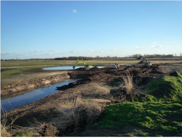
Foto 3 De indertijd genormaliseerde Reusel wordt tijdens de herinrichting gedempt.
