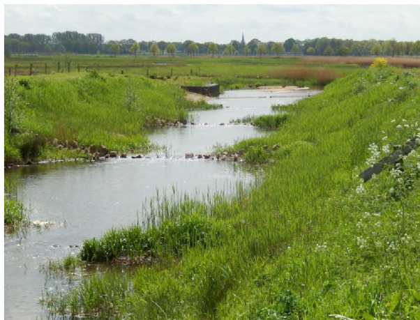
Foto 8 De vistrap in de Reusel ter hoogte van het Wilhelminakanaal.
