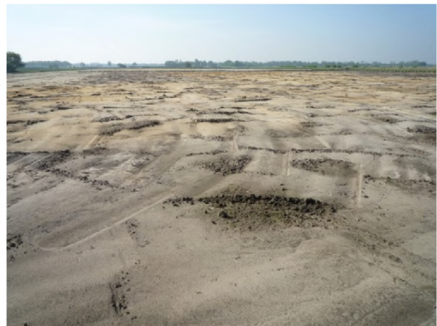
Foto 2 Wanneer de ca. 40 cm dikke zwarte teeltlaag is weggegraven, verschijnt de lichte zandlaag
