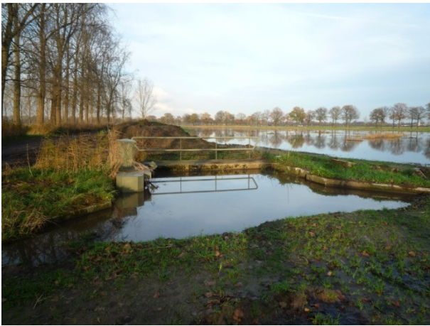
Foto 7 Een niet meer van dienstdoende stuw van de 'oude' Reusel naast het nieuwe stroomdal.
