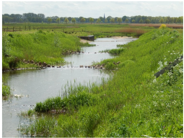
Foto 8 De vistrap in de Reusel ter hoogte van het Wilhelminakanaal.
