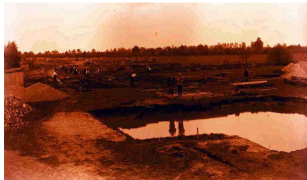
Foto 6 Werkzaamheden tijdens de eerste ontginning van het Diessens Broek omstreeks de 30-er jaren van de vorige eeuw. (archief Ad van Doormaal).
